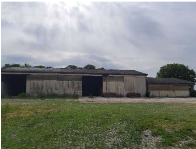
FIGURE 11 : AUTRES BATIMENTS EN FACE DE LA FUTURE BERGERIE
