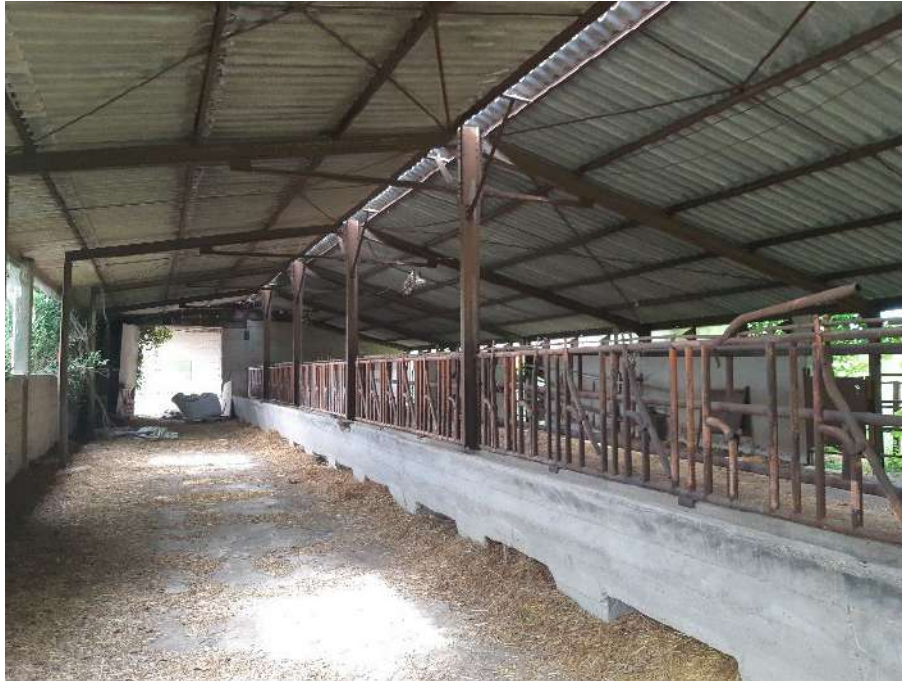
FIGURE 10 : INTERIEUR DE LA FUTURE BERGERIE
